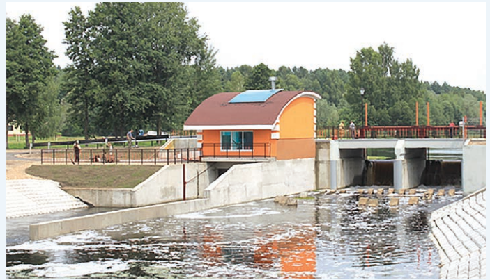
◆ Рис. 5. Мини-ГЭС на гидроузле № 8 «Залузье»
