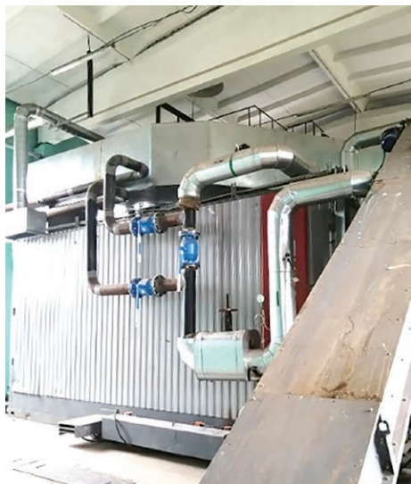
◆ Рис. 5. Вид на котлоагрегат и систему загрузки котельной на щепе в аг. Бабиничи Оршанского района Витебской обл.
