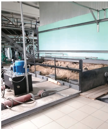
◆ Рис. 5. Вид на котлоагрегат и систему загрузки котельной на щепе в аг. Бабиничи Оршанского района Витебской обл.
