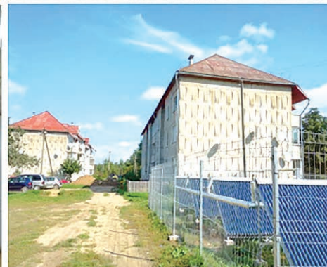
◆ Рис. 6. Вид на гелиоколлекторную систему для обеспечения нужд ГВС двух жилых 18-квартирных домов в населенном пункте Звездная Оршанского района Витебской обл. [12]
