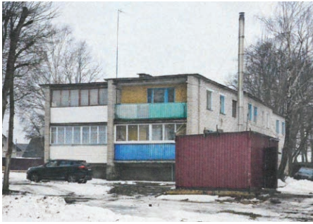
◆ Рис. 2. Вид на модульную котельную по ул. Новой в г. Орша [9]
