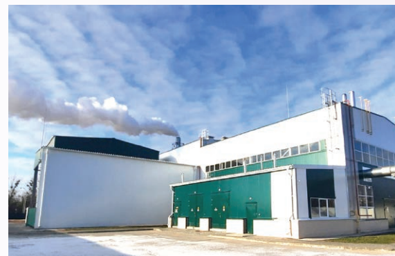
◆ Котельная в г. Щучин
