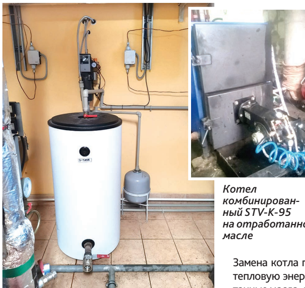
Бойлер косвенного нагрева S-TANK «Р» объемом 200 л
