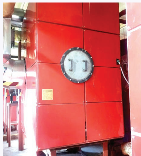
Конденсационный теплоутилизатор для котлов на природном газе
