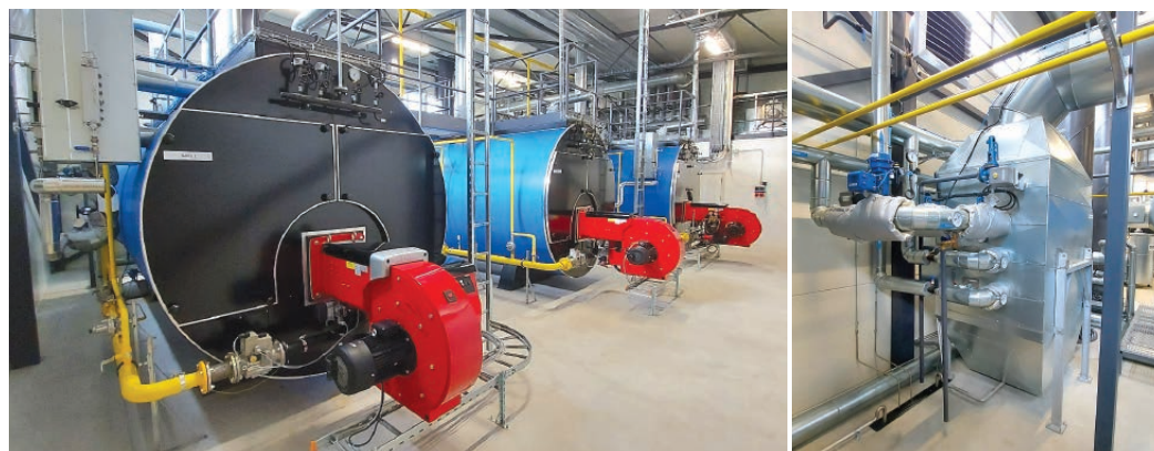
Рис. 3. Котел Danstoker с конденсатором дымовых газов
