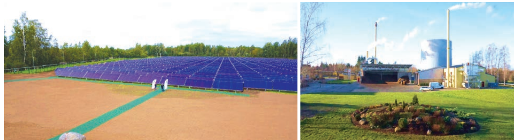
Рис. 4. Городская котельная с твердотопливным котлом, конденсатором дымовых газов, геотермоколлекторной станцией
