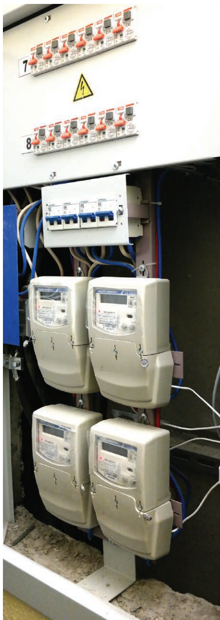
В электродоме в Барановичах для каждой квартиры предусмотрено по два электросчетчика
