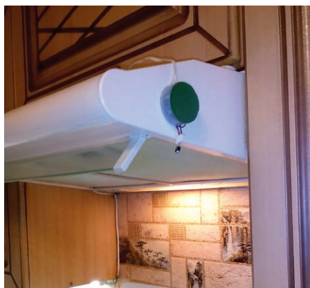
Фото 11. Размещение датчика повышения температуры
