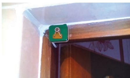
Фото 11. Размещение датчика повышения температуры
